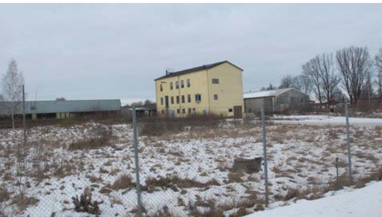
Kranen 2 exteriör från Ekuddsvägen
