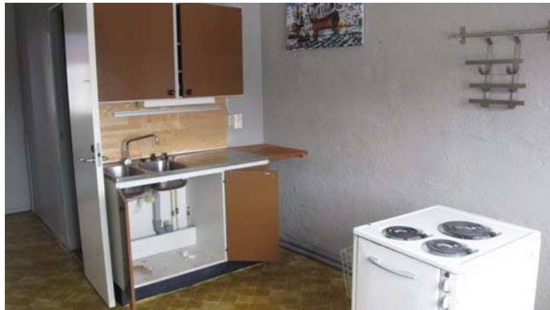
Kranen 2 plan 3, östra delen, kök mot NV
