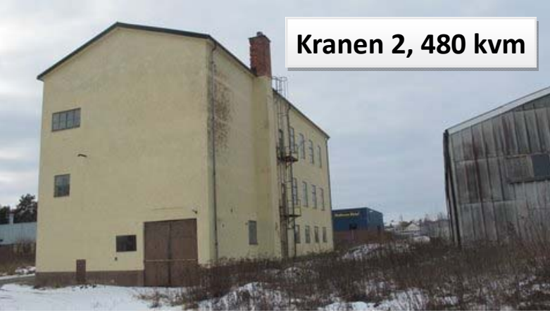
Kranen 2 exteriör från NO
