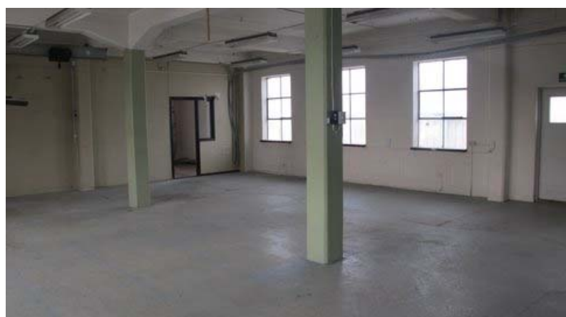
Kranen 2 plan 2, stora hallen mot NV
