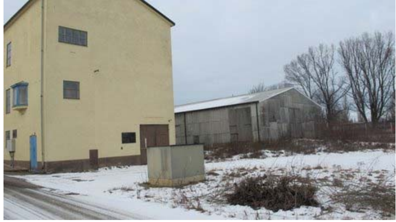
Kranen 2 exteriör från Ö med eternitförrådet
