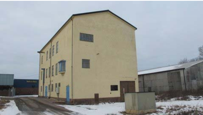
Kranen 2 exteriör från Ö
