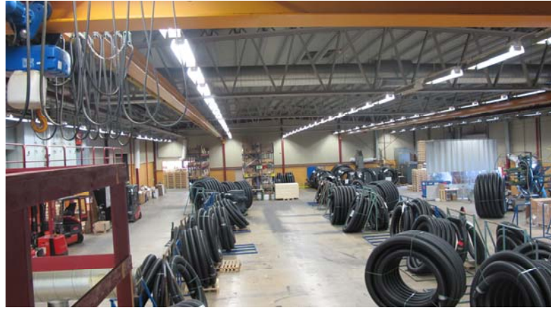
Maskinhall mot Ö översikt, extern port bakom skycket till höger
