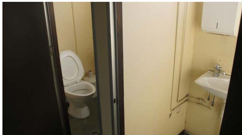
Monteringshallen omklädningsrum damer, tvättställ och toalett
