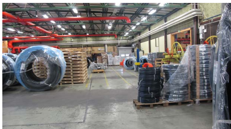
Monteringshall mot S, västra delen
