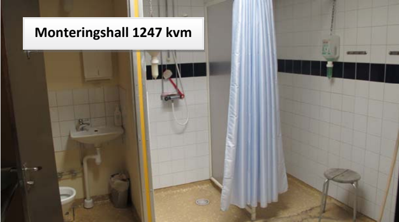
Monteringshallen omklädningsrum herrar mot SÖ
