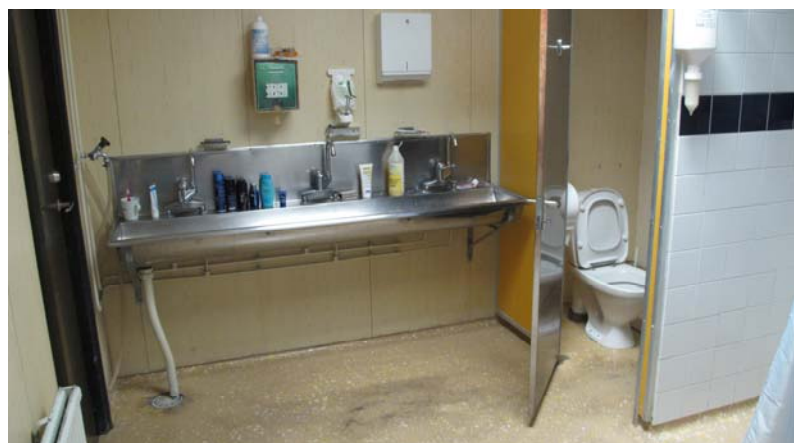
Monteringshallen omklädningsrum herrar mot N
