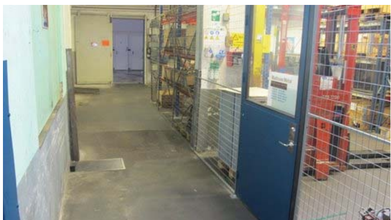
Passagen utanför kontoret med litet lager, 65 kvm, sett mot N
